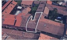
1 Via Pasta 14 Residenziale (Storico)
