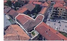
13 Via Monterosa 40 Residenziale (Palazzina)
