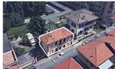
18 Via Monte Grappa 3 Residenziale (Palazzina)
